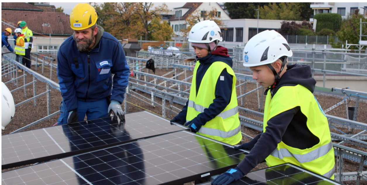
Die Kinder installieren mit grossem Interesse die Solarpanels auf dem Dach des Gebäudes C der Schule Oescher. (Bild: bre)
