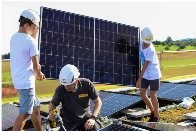
Baustellentag in Gossau
