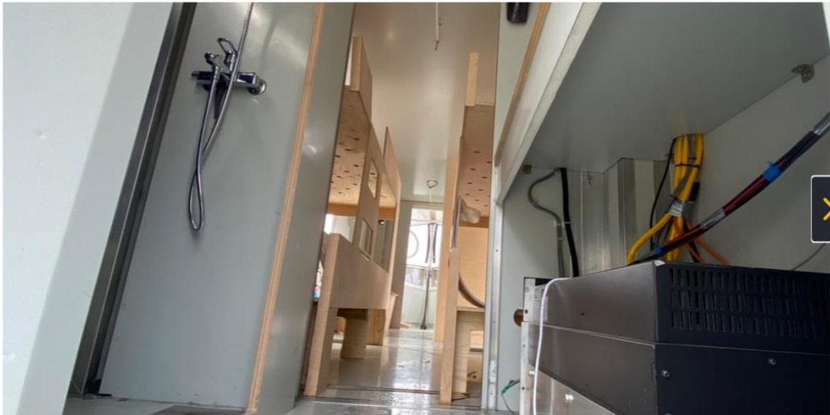
Innenansicht des SolarButterflys: Dusche, Batterien und Betten. Bild: gossau24.ch/yg
