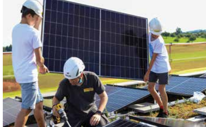
Schülergruppen bauen zusammen mit dem Montageteam eine Solaranlage auf das Schuldach.
