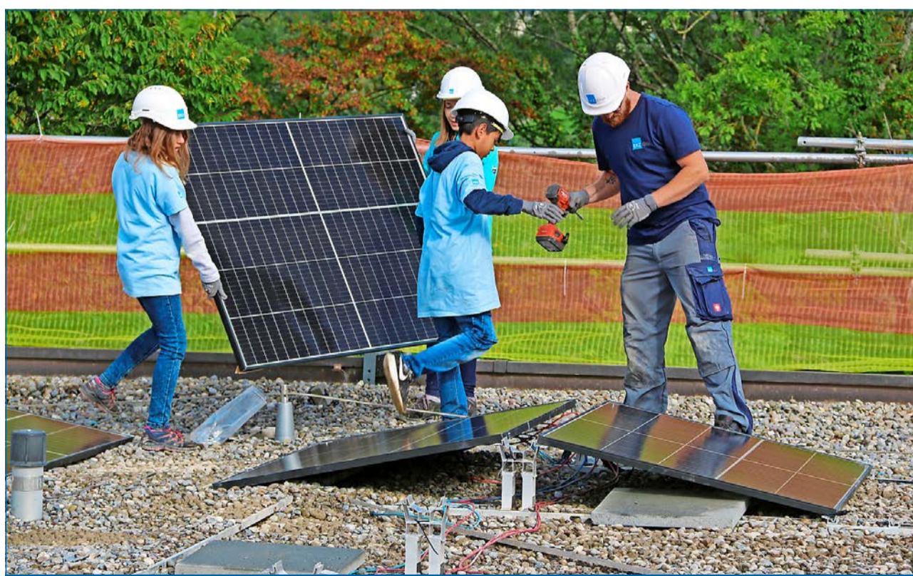
Die Schüler helfen mit, aus dem Primarschulhaus Steinboden in Eglisau ein Solarkraftwerk zu machen. Foto: zvg
