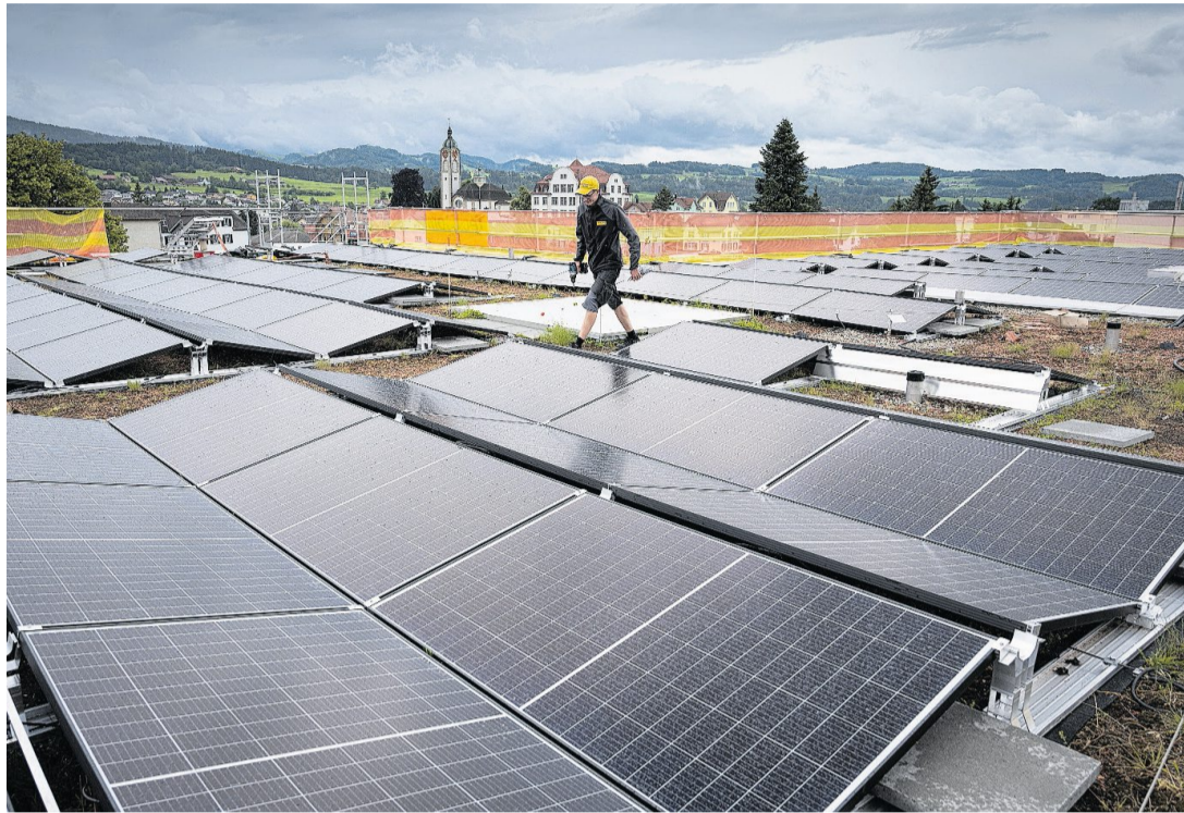
Die Solaranlage soll jährlich rund 139 000 Kilowattstunden produzieren.
