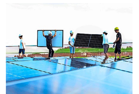
Die Schülerinnen und Schüler bei der Montage der Photovoltaikanlage.
