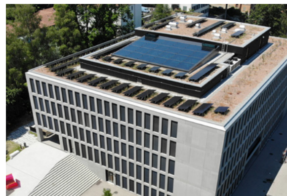
Die Solaranlage auf dem Dach des KBW-Neubaubaus
