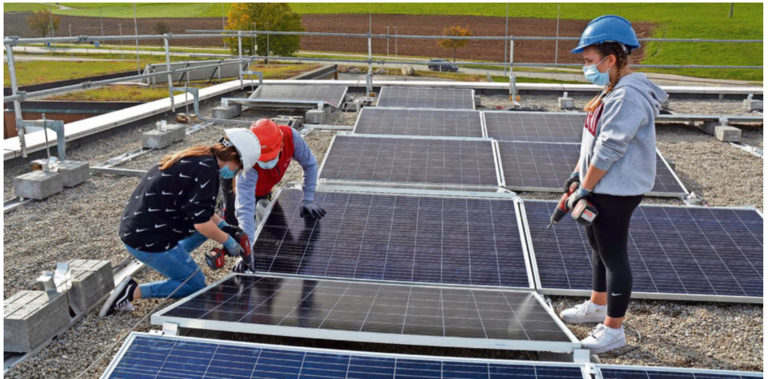
Schülerinnen und Schüler montieren Solarpanels auf dem Dach des neuen Schulhauses. Foto: Laura Hertel
