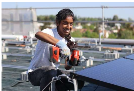
Bild: Schülerin beim Solaranlagenbau am Aktionstag «Baustellentag» des Programms Klimaschule.
