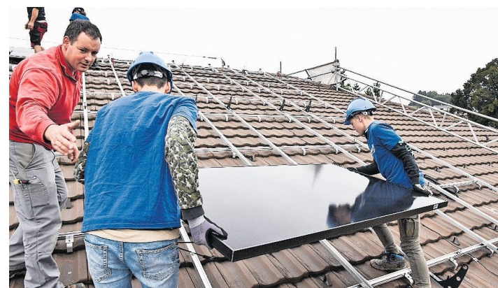
Schüler tragen Solarpanels aufs Dach der Lützel-murg-Halle. Bild: rsc
