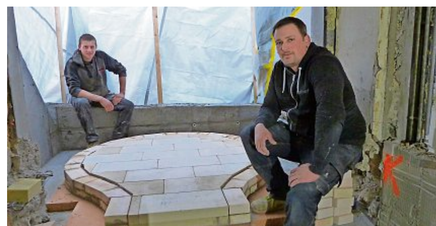
Im Restaurant Barone, der ehemaligen Linde, wird ein Pizzaofen aus 500 Steinen zusammengesetzt. Er wird ungefähr drei Tonnen wiegen. kull
