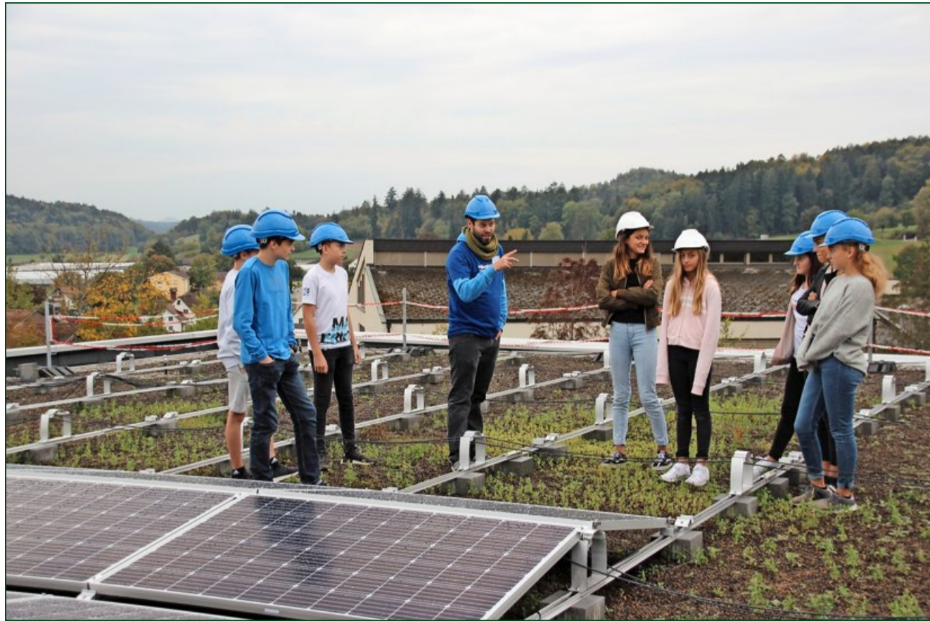
Die Schüler haben mitgeholfen, die Solaranlage auf dem Dach der Doppelsporthalle zu installieren. Foto: PD
