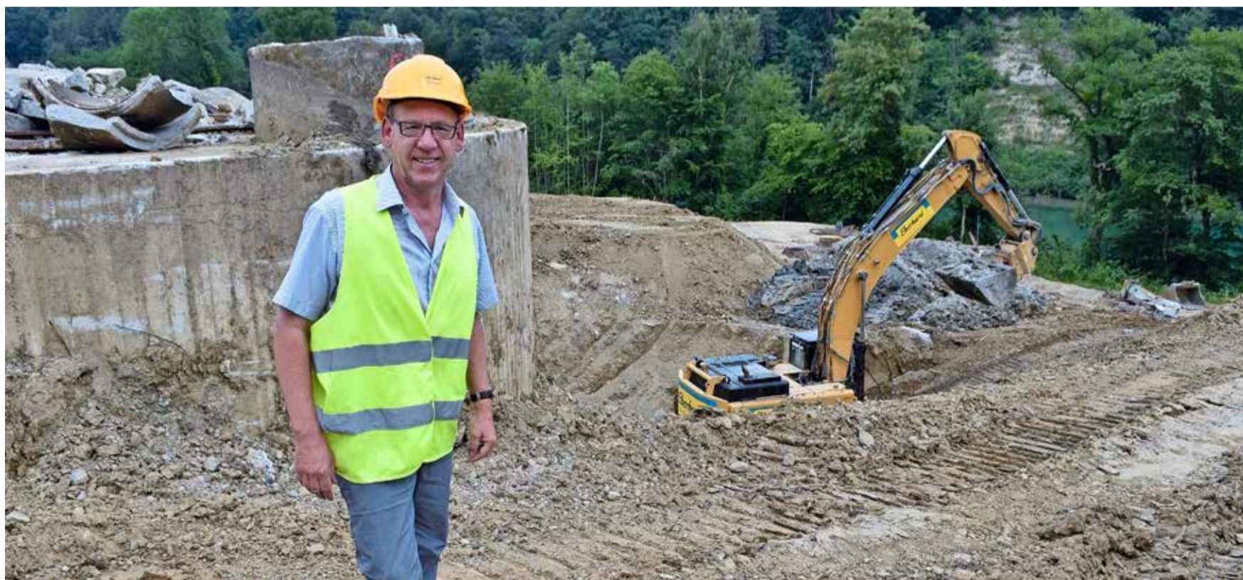
Projektleiter Urs Eberle hat alle Hände voll zu tun. Die Firma Eberhard Bau AG Kloten ist als Totalunternehmer für alle Bereiche des Rückbaus zuständig.
