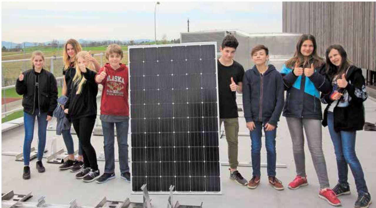
Nach dem Motto «Das ist Lernen fürs Leben» halfen einige Sektischüler mit, eine Solaranlage auf das Dach der Schule zu bauen.
