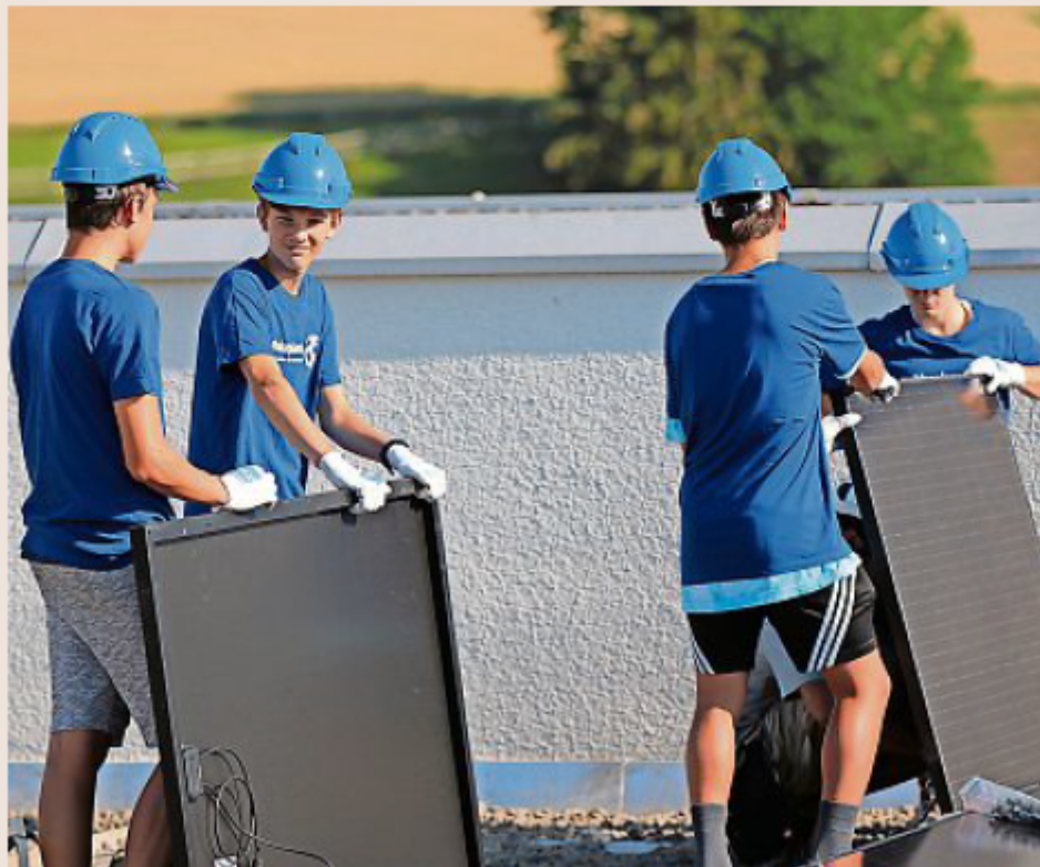
Einsatz auf dem Schulhausdach in Elsau: Die Photovoltaik-Anlage wird montiert. z.V.g
